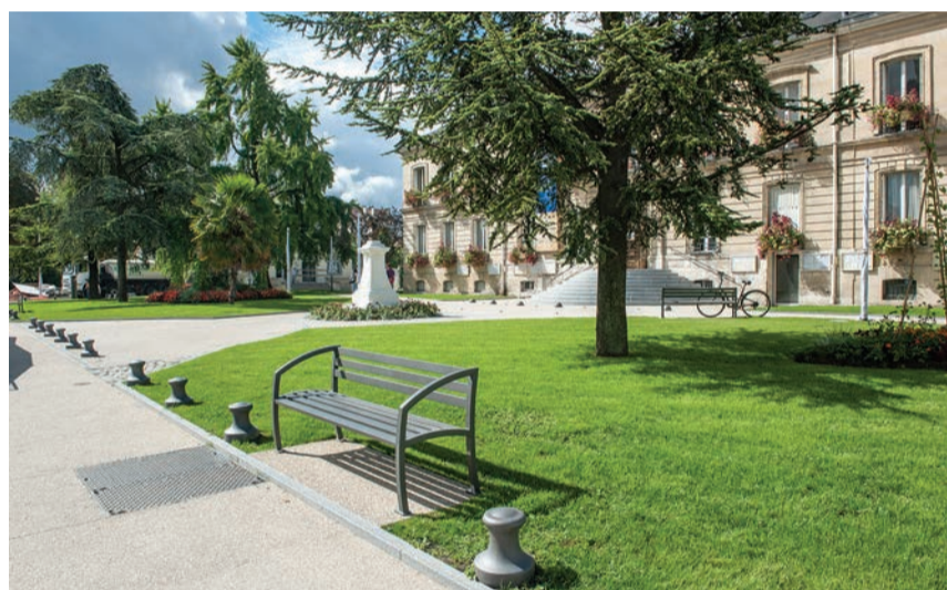
Le parvis de l'hôtel de ville totalement rénové.
